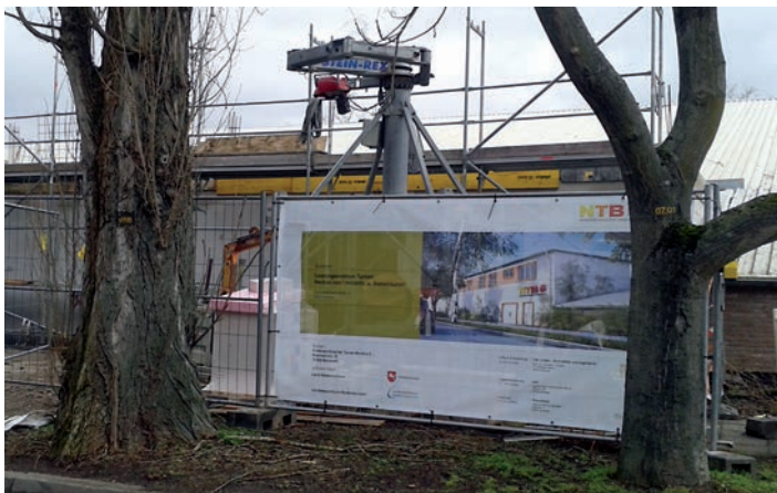
Der Anbau des Turnzentrums Hannover-Badenstedt feiert bald Richtfest.
